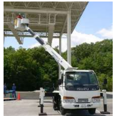
高所作業車実習
