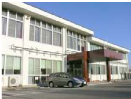
研修センター本館
